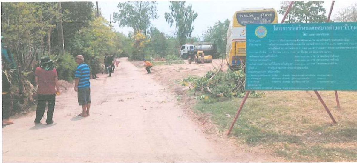
ระหว่างดำเนินงาน
